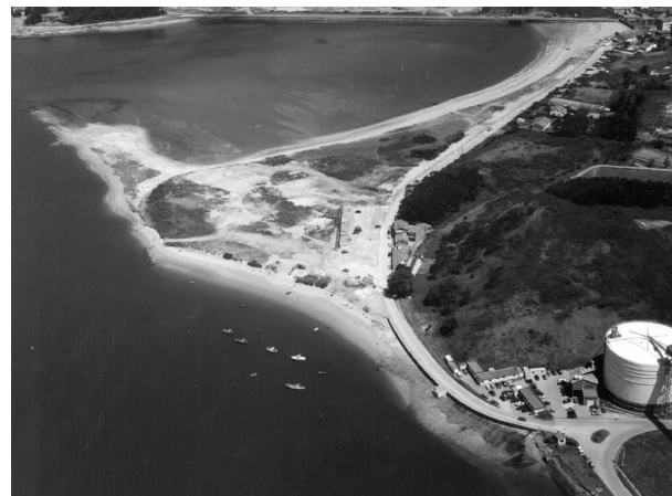
Figura 6.- Vista aérea del resultado de las operaciones de dragado.
