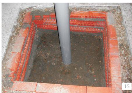
15. Arqueta captadora bajo solera. Las paredes se ejecutaron con ladrillo perforado.
