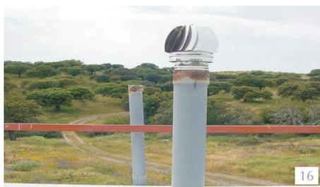
16. Tuberías de expulsión hasta cubierta. PVC 110 mm.
