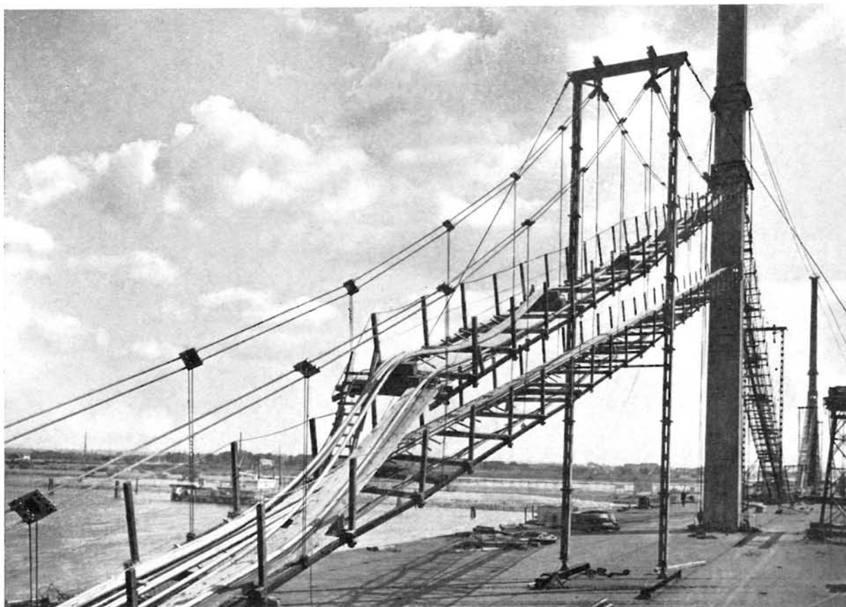
Colocación de cables de suspensión.
