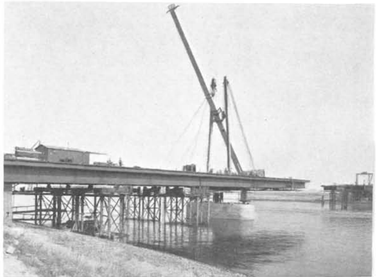
Montaje de una torre.
