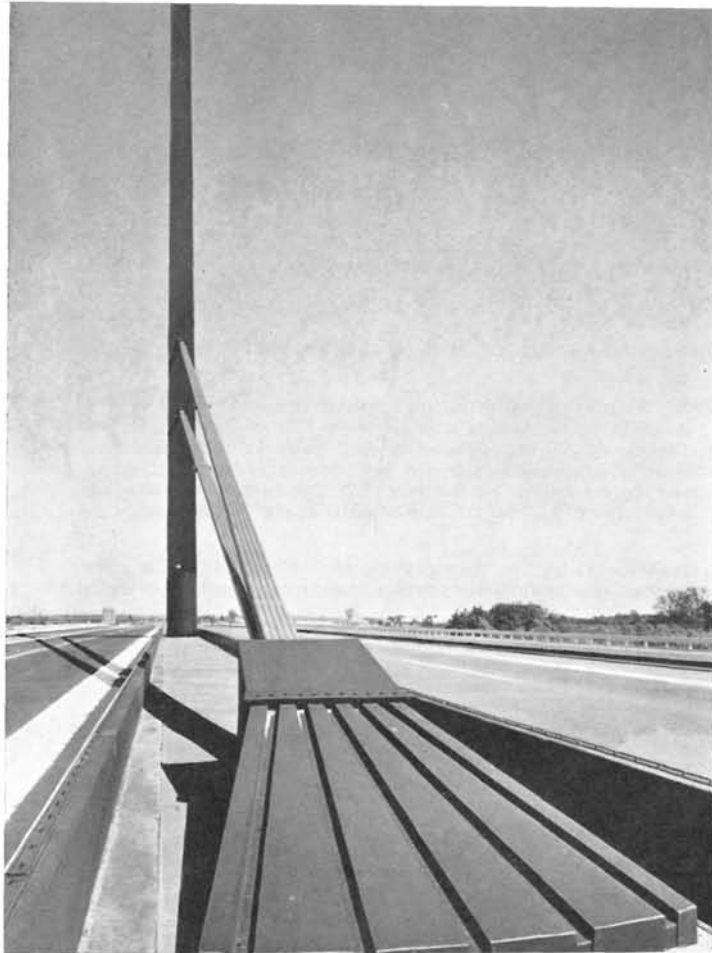
Separación de cables abiertos en abanico. El puente en servicio.
