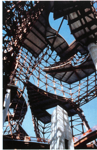
Montaje de la estructura metálica.
