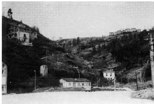
Foto 5.- Vaguada de Ugasko. El trazado previsto originalmente pasaría en primer término, lo que afectaría a viviendas y servicios en el lugar. Según la alternativa, se salvaría esta vaguada mediante un viaducto, al fondo de la fotografía.
