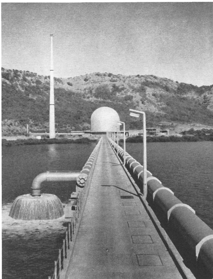
**Destructor de energía de la salida del agua de refrigeración.
