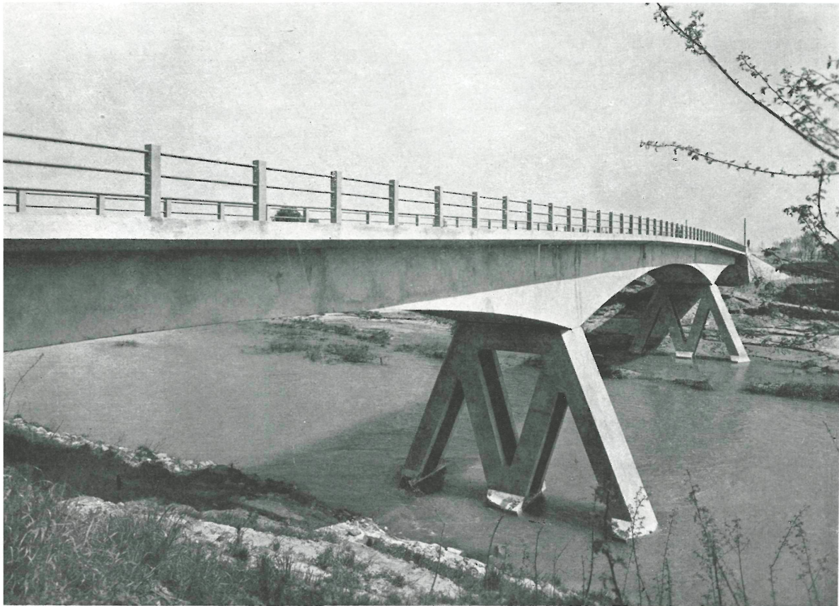
Aspecto general del puente mostrando los dos soportes intermedios en M y su armoniosa línea arquitectónica.
