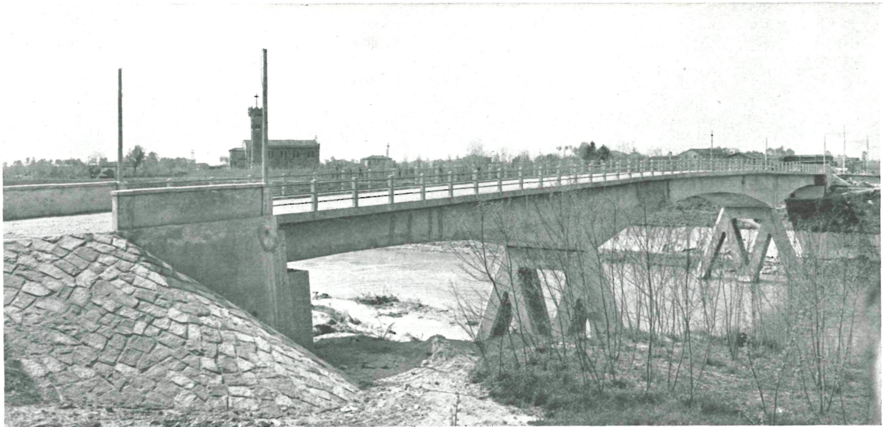
Los derrames del terraplén del acceso se han revestido con mampostería ordinaria para evitar la erosión.
