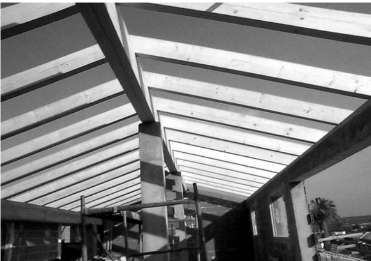
Figura 13. Cubierta de entramado pesado. Par y picadero.
