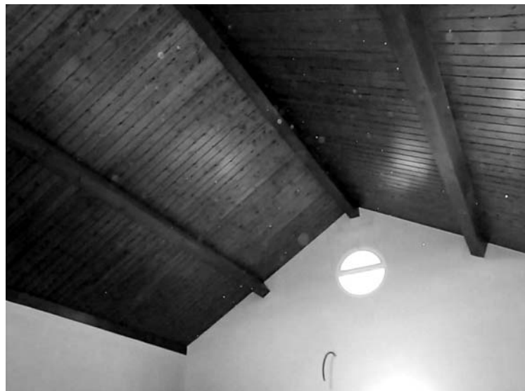
Figura 8. Cubierta a la molinera de entramado pesado de madera.
