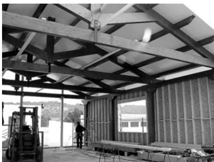
Figura 16. Cerchas de entramado pesado resueltas con uniones tradicionales.
