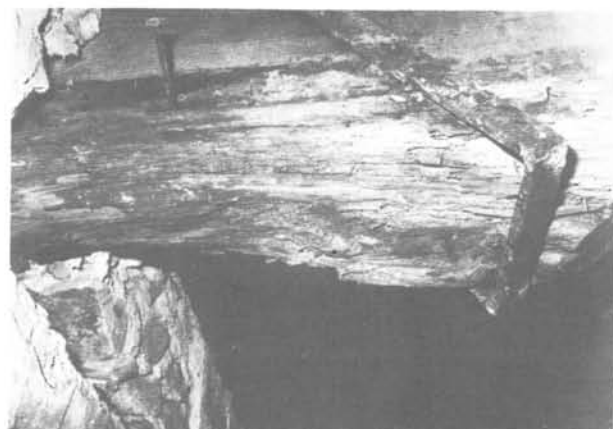
Cornisa y apoyo de formas.
