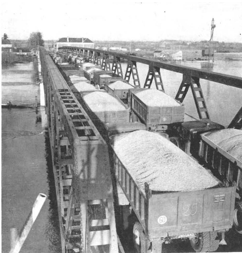
En el puente Grand Bras se debían levantar 1.200 toneladas. Los gatos se colocaron: dos en cada estribo, y cuatro en cada una de las dos pilas intermedias de nueva construcción.
