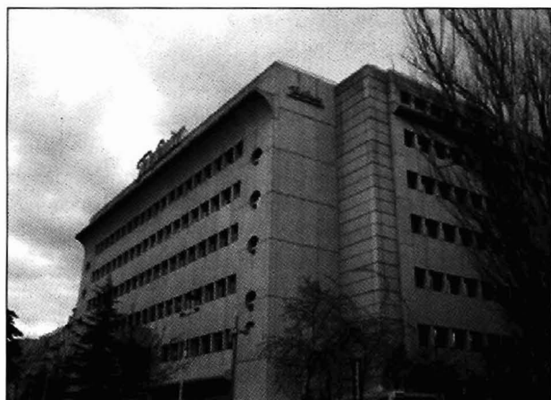
Figura 2.- Edificio de TID en Madrid.
