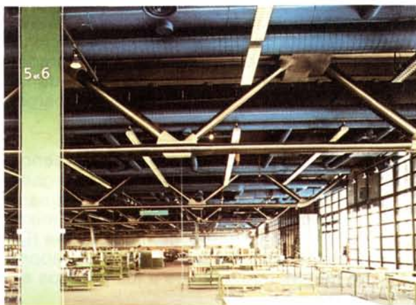
Fig. 13.—Centro Georges Pompidou. Vista inferior de vigas en celosía.
