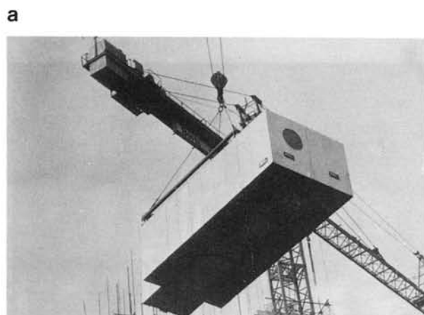
Colocación de cápsula prefabricada de servicios.
