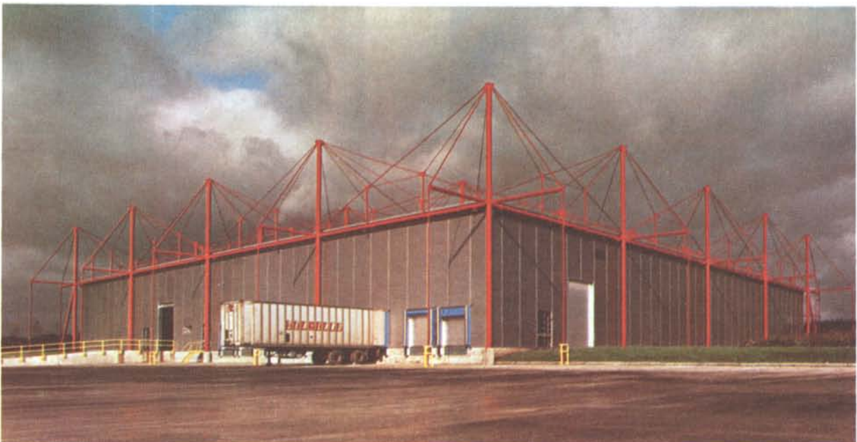
Fig. 26.—Centro de producción y distribución Quimper. Francia. Vista general.
