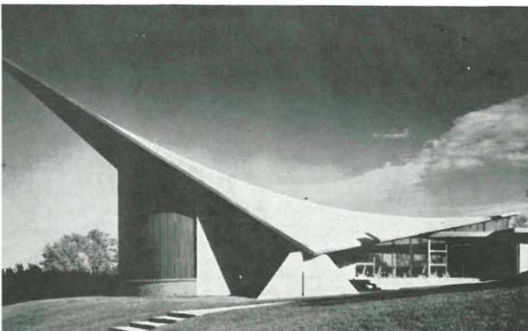
Figs. 24 a, b, c.—La cubierta de la Iglesia Episcopal de San Edmundo, Elm Grove, Wis., presenta una lámina en paraboloid hiperbólico de 3 pulgadas de espesor, apoyada en dos pequeños estribos de hormigón. La inclinación de la forma en silla de montar aumenta el efecto de grandiosidad en el santuario. Arquitecto: Wm. P. Wenzler de Milwaukee, Wis. Contratista general: Gebhard-Berghammer, Inc., de Milwaukee.
