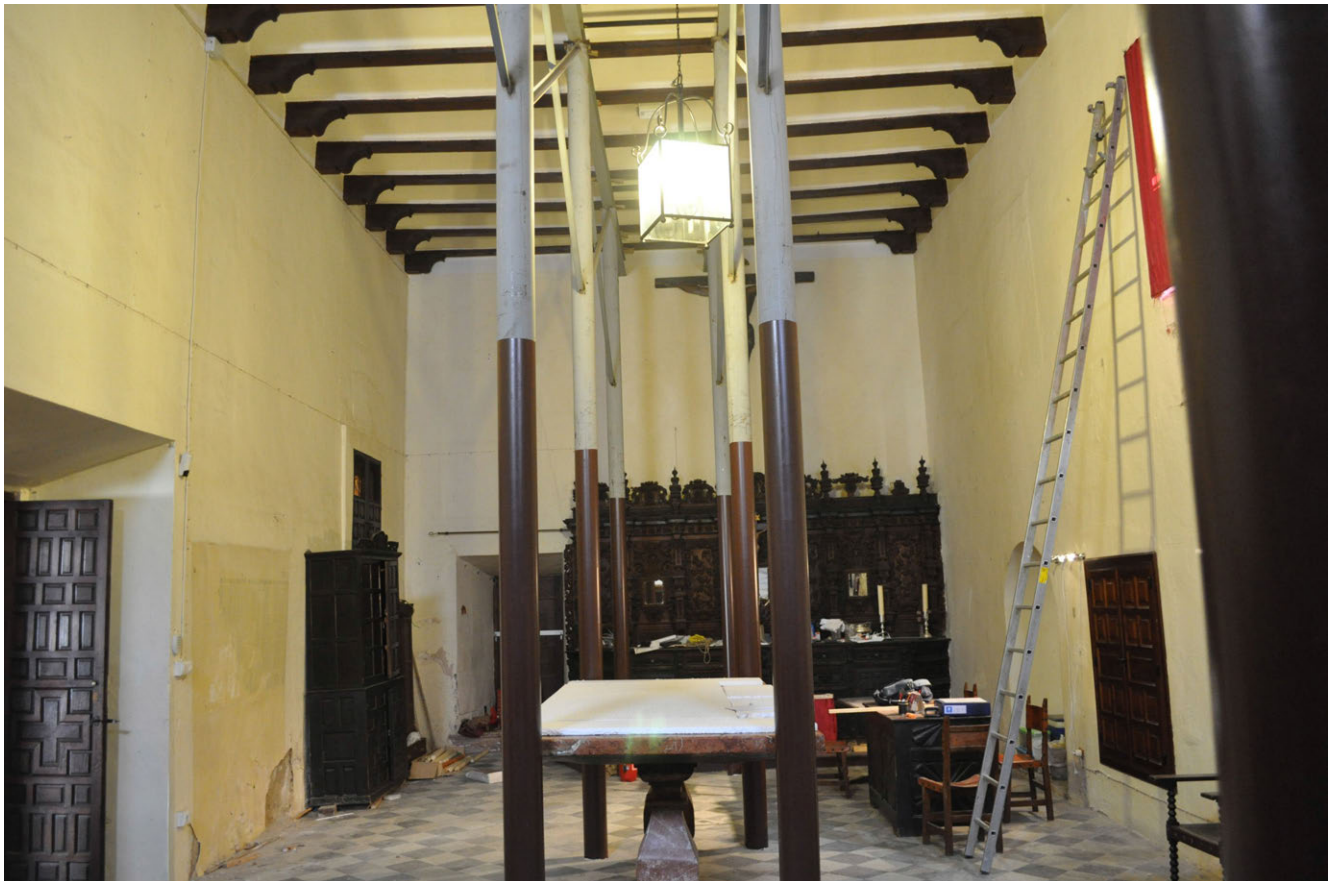
Figura 4. Vista inferior del forjado con el apuntalamiento, justo antes de la intervención.
