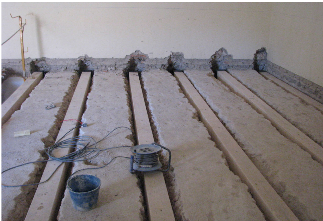
Figura 10. Forjado reforzado con los refuerzos ya encolados.
