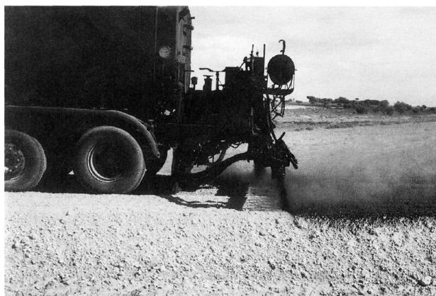
Fig. 7.- Segundo pase de cisterna de riego con emulsión.
