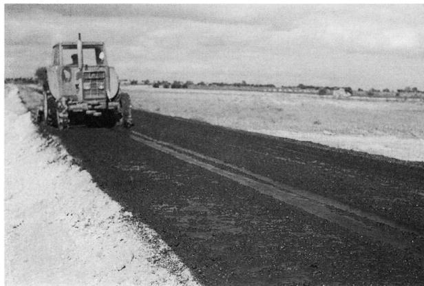
Fig. 4.- Primer pase de fresadora.
