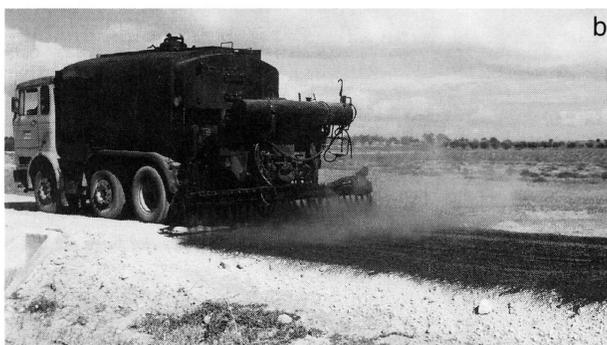
Fig. 2.- a) Primer riego con emulsión asfáltica. b) Primer riego con emulsión asfáltica. Detalle de cisterna con rampa.
