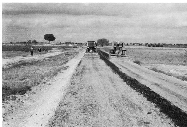
Fig. 8.- Detalle del segundo pase de fresadora. Detalle de mezclado.
