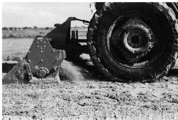
Fig. 5.- Primer pase de fresadora. Detalle de mezclado.
