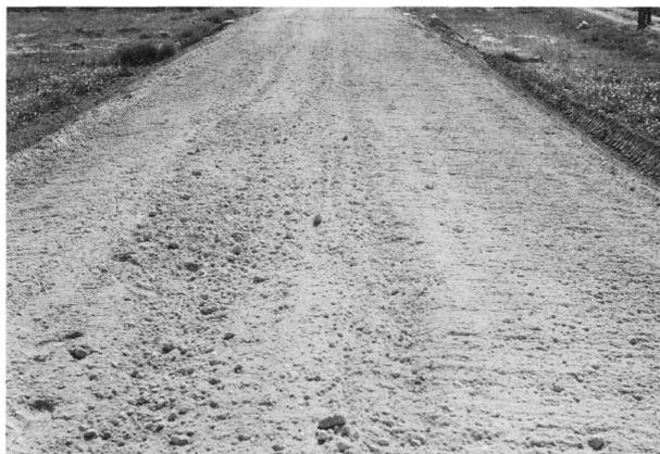
Fig. 1.- Zaborra natural extendida sobre caja previamente formada.
