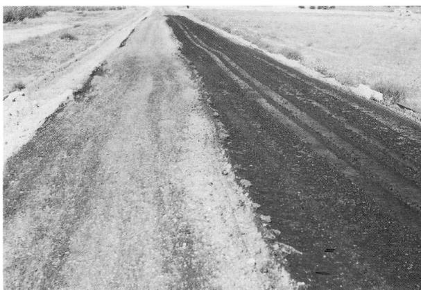
Fig. 3.- Aspecto del tratamiento después del pase de cisterna.
