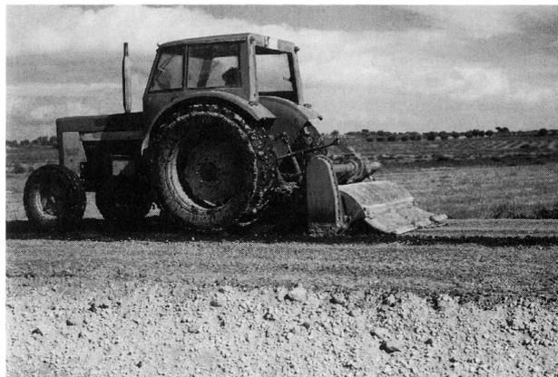
Fig. 6.- Detalle del segundo pase de fresadora. Detalle de mezclado.
