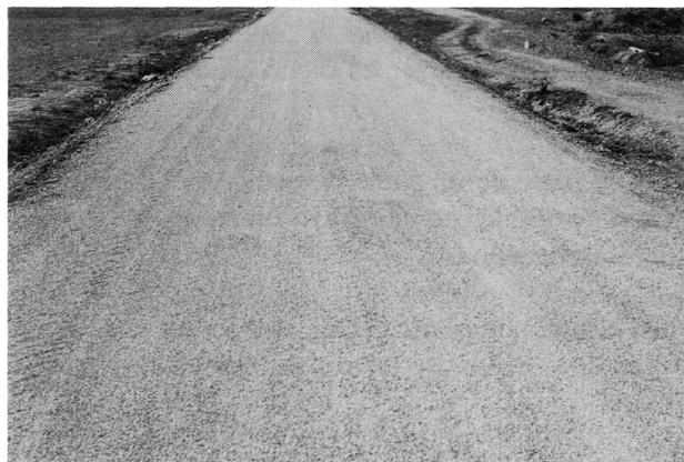
Fig. 13.- Aspecto con riego adicional de sellado a base de tratamiento superficial asfáltico.
