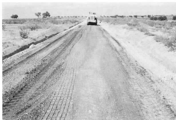
Fig. 11.- Compactación con vibro liso autopropulsado.
