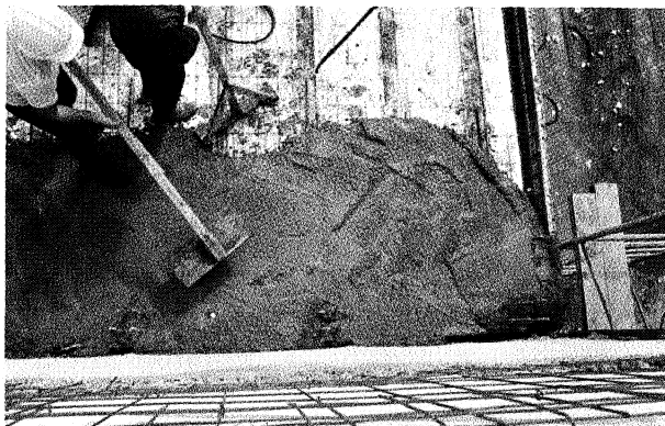
Foto 11. – Hormigonado capa de compresión.
