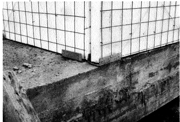
Foto 5. - Sujeción provisional de paneles.
