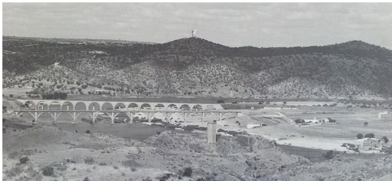
Figura 10. Vista del vado de Alconétar hacia 1950. Se observan los puentes carretero, ferroviario y las pilas del de Eiffel en los vanos no consecutivos de este último.
