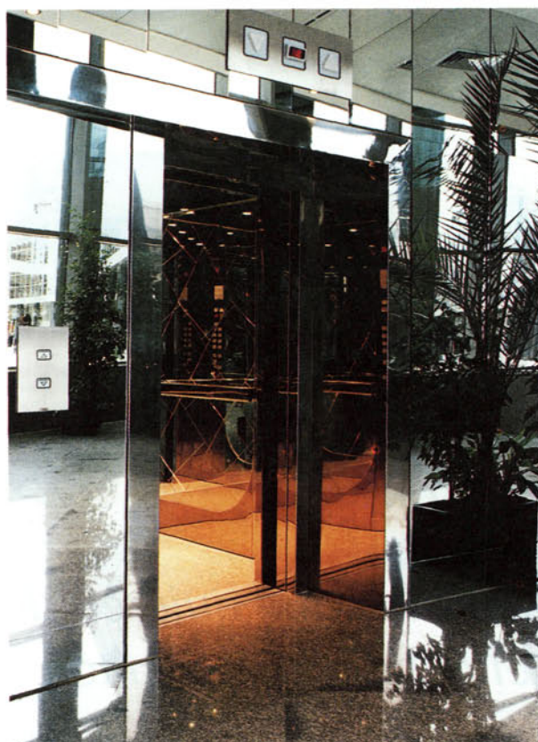
Vista de ascensores.
