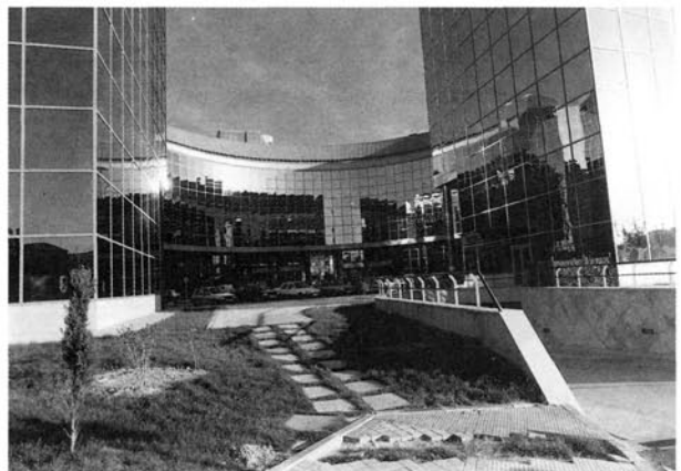
Vista de una de las entradas de acceso al garaje.
