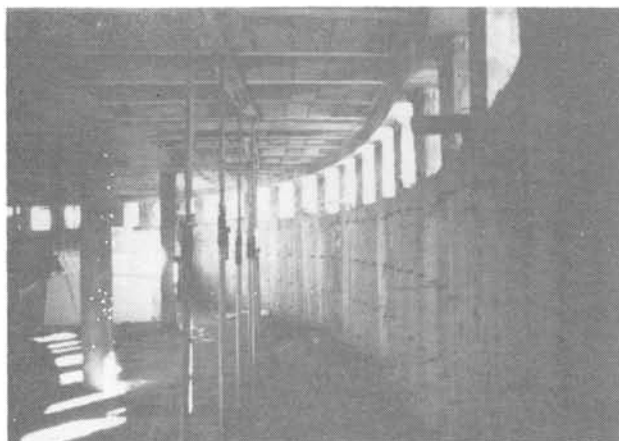
Sotano del polideportivo en construcción.
