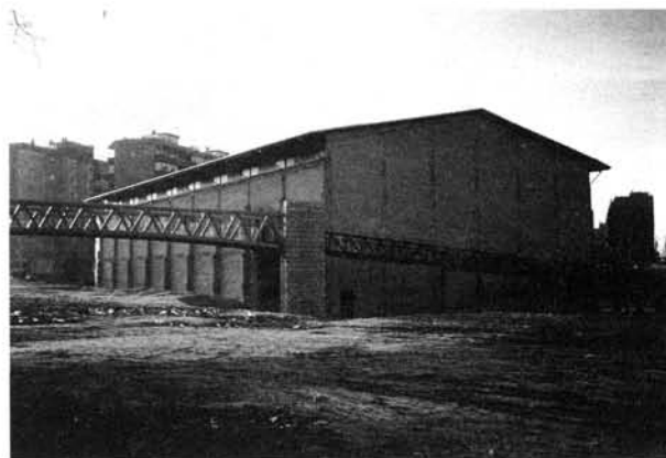
Vista del polideportivo desde la pasarela peatonal.
