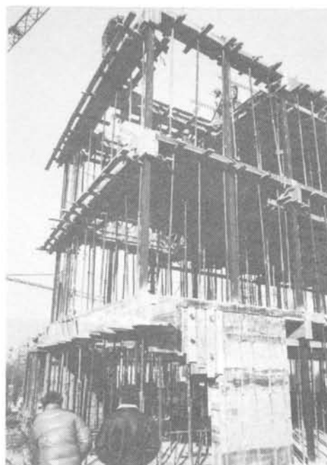
Centro cívico en construcción.
