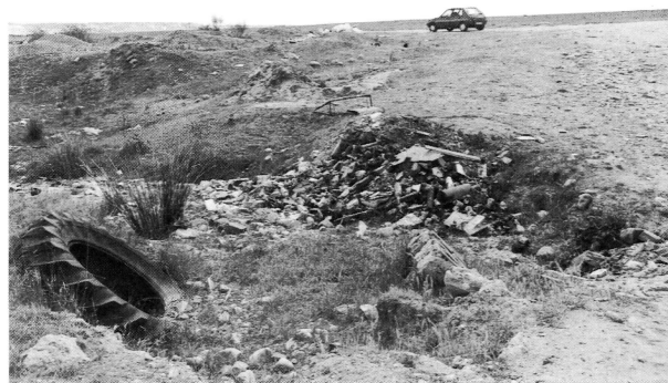
Foto 3.- Basuras en el cauce.
