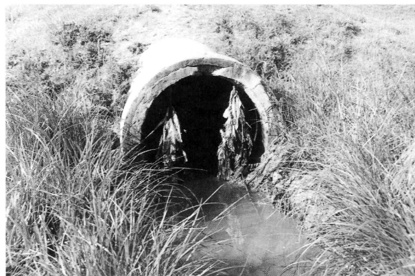
Foto 1.- Aliviadero del colector de aguas residuales. Tramo 1.
