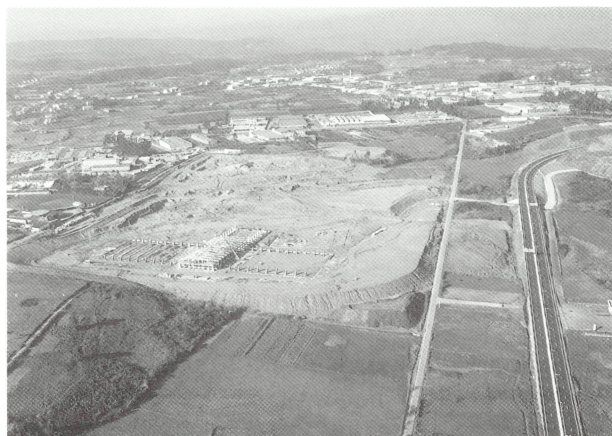
Fig. 3.- Vista aérea del estado de las obras (marzo 1995).
