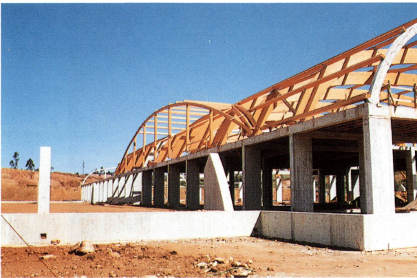
Figs.6 y 7.- Estructura del edificio de servicios.
