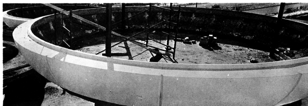
colocación de encofrados perdidos de plástico y hormigón
