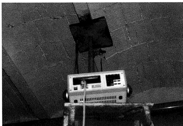
Fig. 2.—Corrosímetro "GECOR" midiendo en un forjado.
