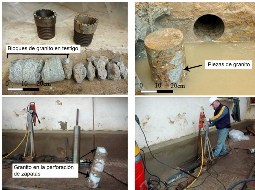
Figura 7. Perforación de las zapatas. Testigos (15 cm diámetro) extraídos donde se aprecia el uso de granito en la cimentación y equipo para su perforación.
