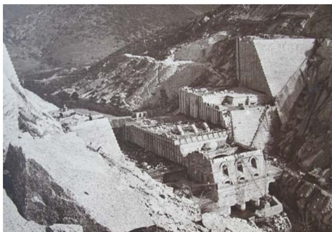
Figura 3. Vista de la presa de La Jándula en construcción, 1 de diciembre de 1928. (Fuente: Cía. de Canalización y Fuerzas del Guadalquivir) (13).
