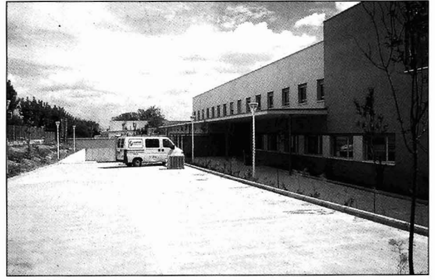
Fachada posterior. Acceso servicio.
