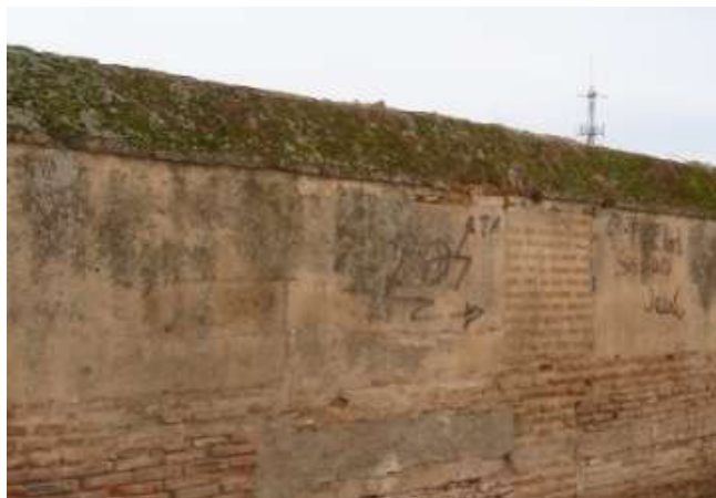
Figura 1. A la izquierda remate de una tapia con hiladas inclinadas, a la derecha cornisa de ladrillos con vegetación y donde se han desprendido varias piezas.
