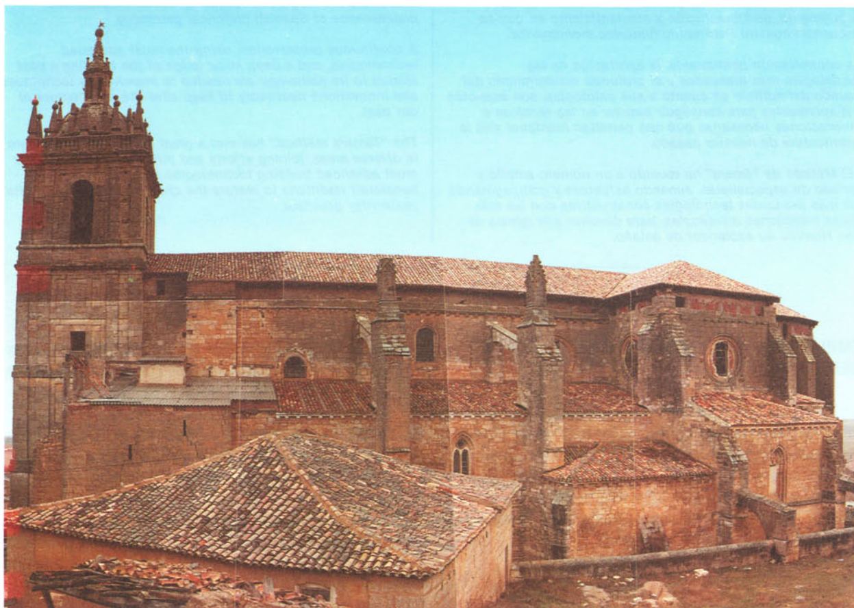
Fig. 2.— Panorámica del exterior. Estado actual. Alzado Epístola sureste.
