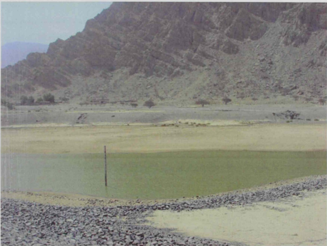
Figure 1.3. View of Wadi Al-Bih dam.
