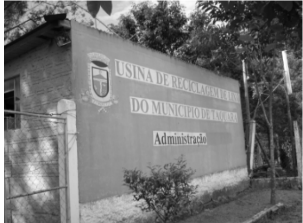
Figura 07 - Registro fotográfico do usina de reciclagem do município de Taquara.
