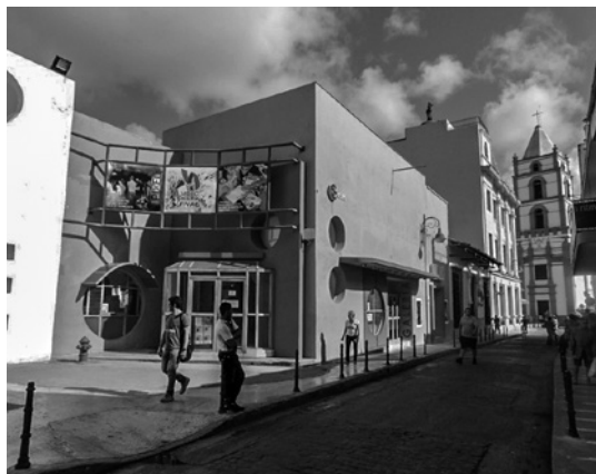
Figura 12 Paseo de los Cines, calle Ignacio Agramonte, luego de la intervención. Fuente: Fotografía de Elvira Sariol.
