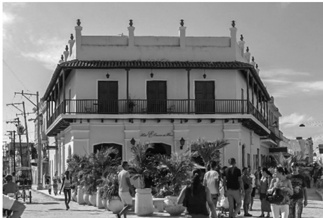
Figura 11 Vista del hostel, El Camino de Hierro, después de la intervención. Arq. Yosmel Díaz y equipo. Fuente: Archivo OHCC.
