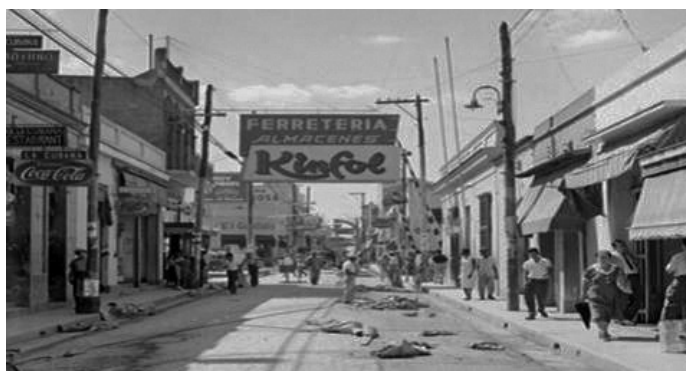
Figura 5 Vista de la calle República durante la república (1950). Fuente: Archivo de la Oficina del Historiador de la Ciudad.
