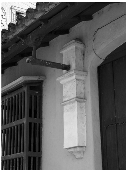
Figura 3 Fachada tradicional camagüeyana. Alero de tornapunta típico de la ciudad (2015). Fuente: Archivo de Oscar Prieto.
