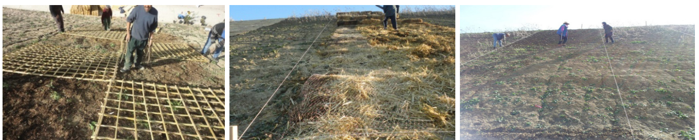
Figure 7: Pose des plaques de roseaux en maille (gauche); Fixation du paillage de paille avec un grillage fin (milieu) et Tracé des lignes à semer (droite)
