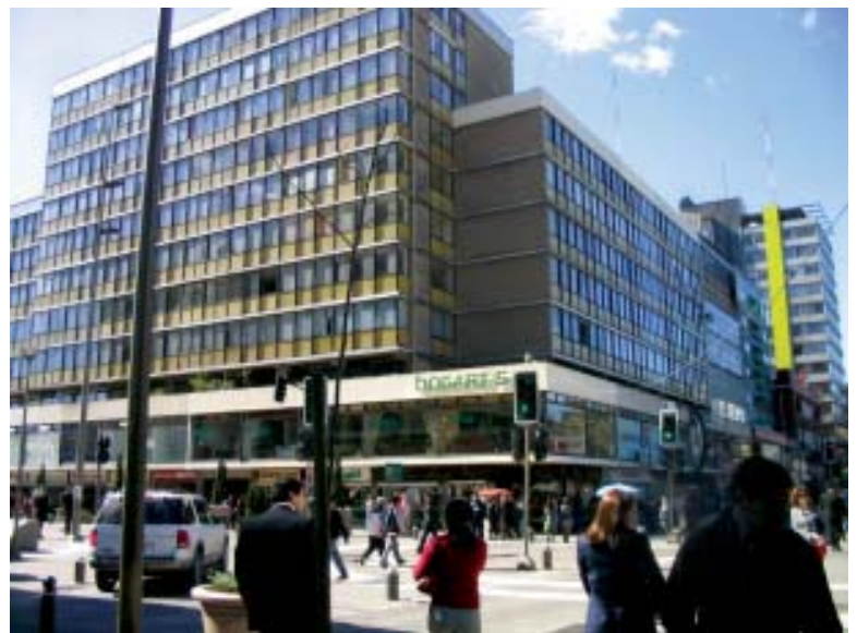
Edificio Fiuc de la llamada “arquitectura moderna”, levantado en pleno centro de la ciudad de Concepción.
