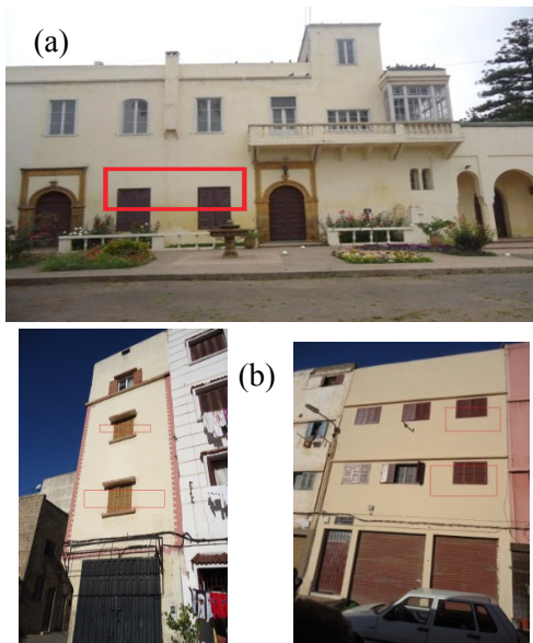
Figure 1: (a) Ancienne résidence du général Lyautey, (b) Exemple de façades de bâtiments. Les cadres rouges présentent les plans des volets de fenêtres et des murs qui coïncident.
