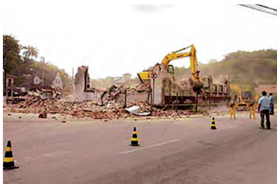
Figura 3 Inicio de demolición en Diciembre de 2005. (Fuente: Jornal de Santa Catarina, 05/12/2005)
