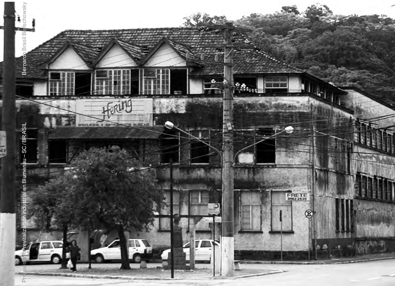
Figura 1 Ejemplo de una edificación industrial abandonada (Fuente: Bielschowsky, 2001).
