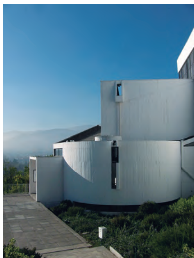
Figura 4 Vista lateral del acceso. Fotografía: Rubén Muñoz.
