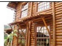
Proteção das janelas com coberturas exclusivas
