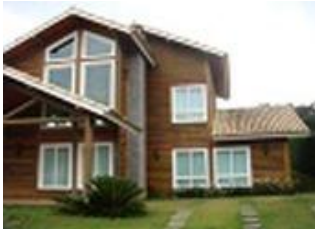
Residência 02, EMPRESA B
