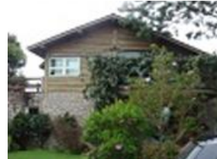
Residência 03, EMPRESA B
