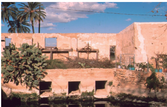
Figura 1 Visión panorámica de la Huerta de Murcia \ Figura 2 Plano medio y estructura del paisaje \ Figura 3 Elemento del paisaje. Molino hidráulico de Funes, s. XVII-XVIII.
