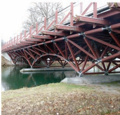
Figura 1. Puente sobre el río Isar en Thalkirchen, Alemania. (Dietrich 1993).
