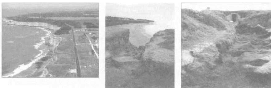
Fotos 3, 4 y 5: ACANTILADOS COSTEROS Y PROCESOS EROSIVOS MANIFIESTOS
