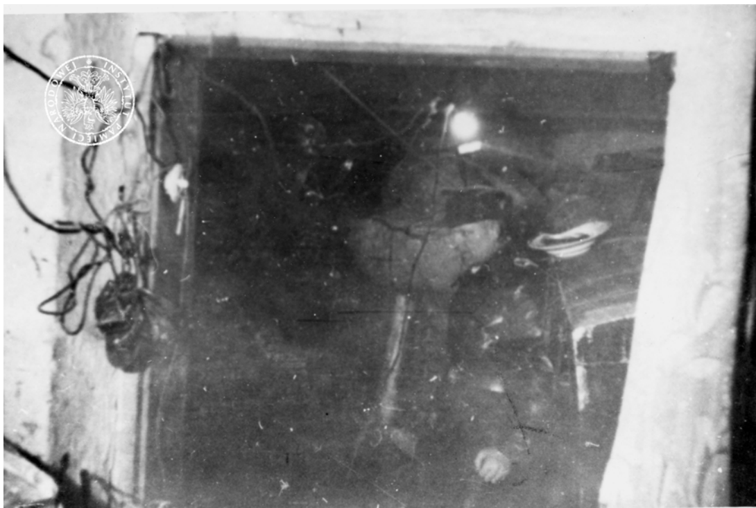
„Przejście do drugiej piwnicy” (Katzmann, 2001, s. 75) – fotografia ze zbiorów Biura Udostępniania i Archiwizacji Dokumentów Instytutu Pamięci Narodowej – Komisji Ścigania Zbrodni przeciwko Narodowi Polskiemu (IPN BU, GK_22413) © Copyright by Instytut Pamięci Narodowej – Komisja Ścigania Zbrodni przeciwko Narodowi Polskiemu)
