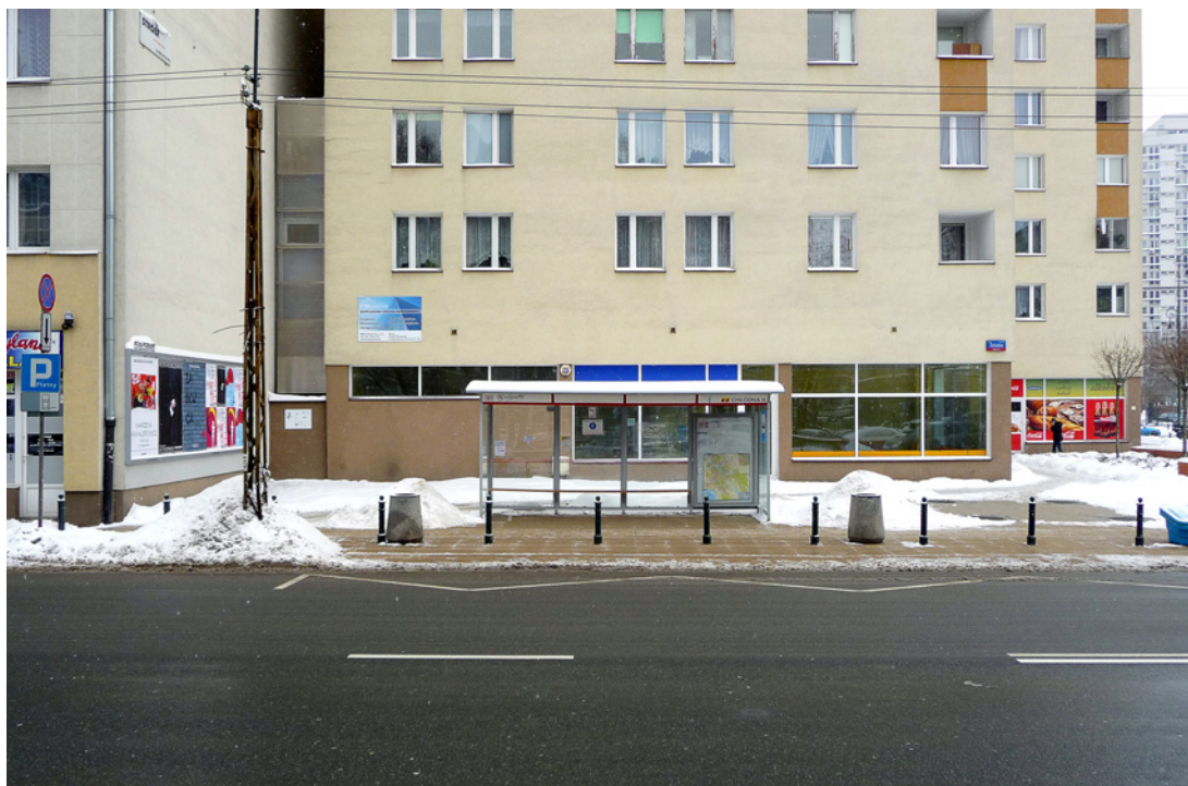
Największy dom świata (architekt Jakub Szczęsny), zbliżenie – szczelina między Żelazną 74 a Chłodną 22, Warszawa, styczeń 2013. Fot. Elżbieta Janicka
