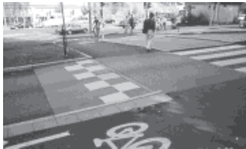
写真 6, 7: 歩道と同じ高さのハンブはあとから道路の上に盛り上げて作った応急措置的なつくりであるが、車は必ずとまらねばならない勾配になっている。
