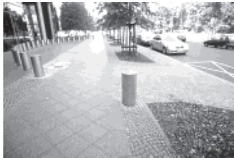
写真10: バイアス上に敷き詰められた舗石と両脇のピンコロ石。舗石の上には障害となるものはおいてない。
