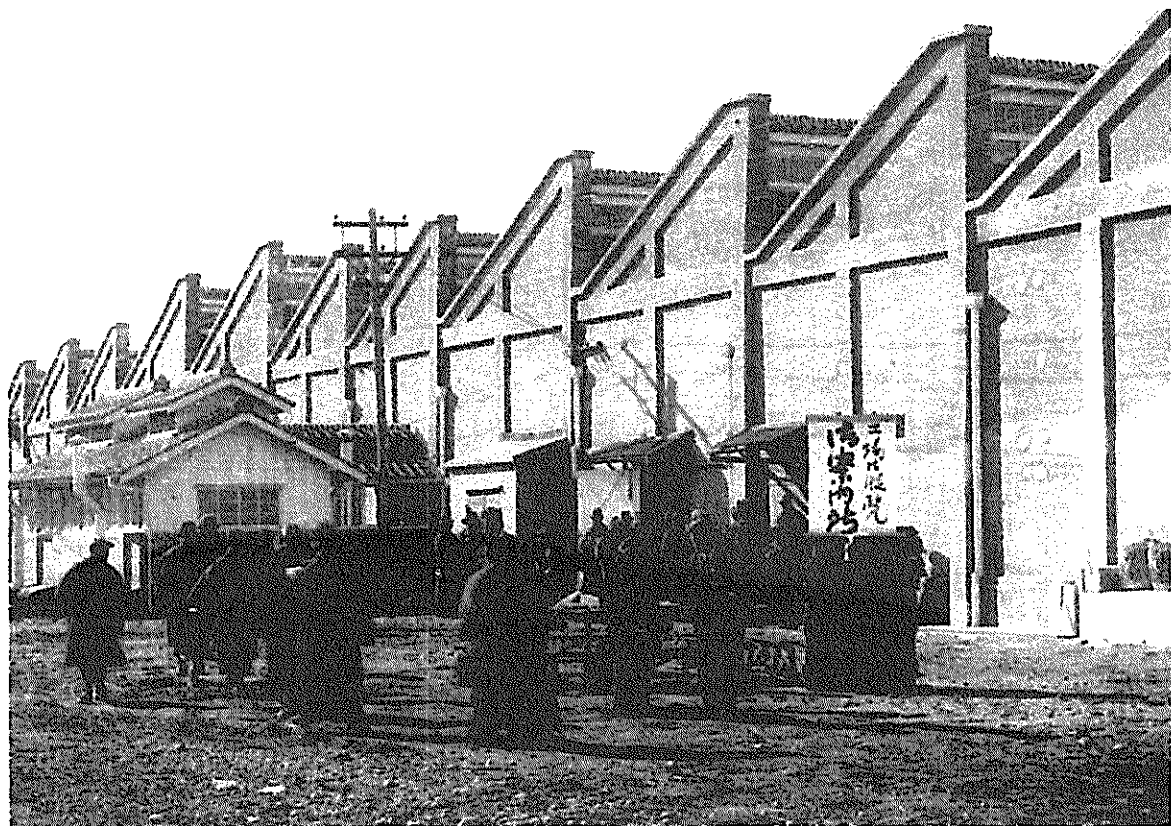
写真-5 日清紡績浜松工場開業記念絵葉書。第 1 工場の東側の写真と思われる。この時点では工場棟からの差しかけ屋根（下屋）がない。
