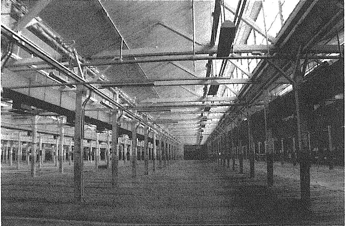
写真一六 第 1 工場の現在の内部：木造鋸屋根、多柱大空間。洋風の構造を日本の大工が施工。これだけの規模で現存するのは珍しい。第 2 工場も同じ。
