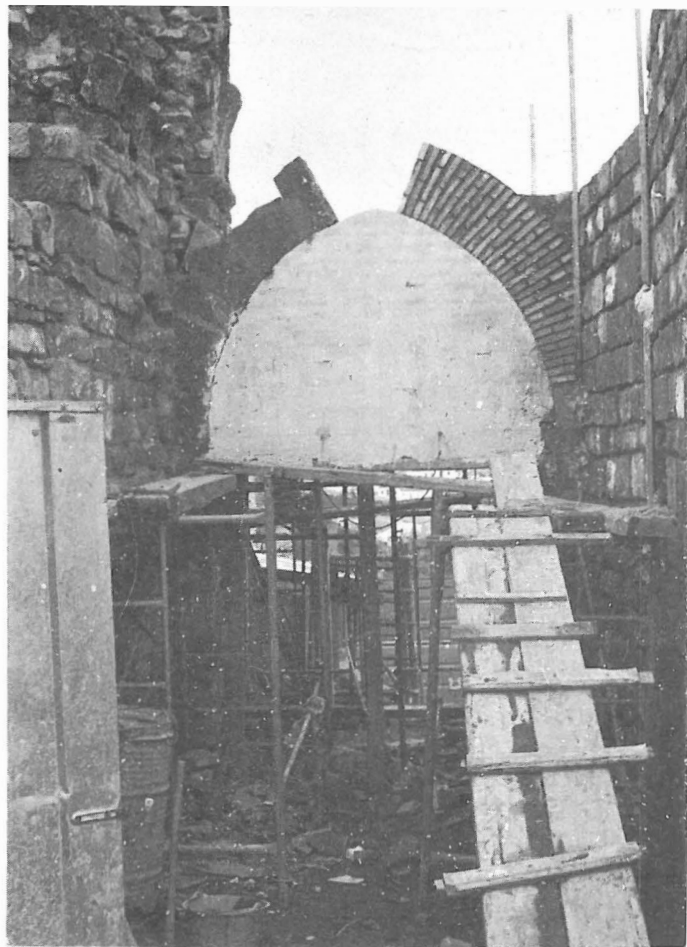
Foto 6. Replantes del arco y análisis de materiales.
