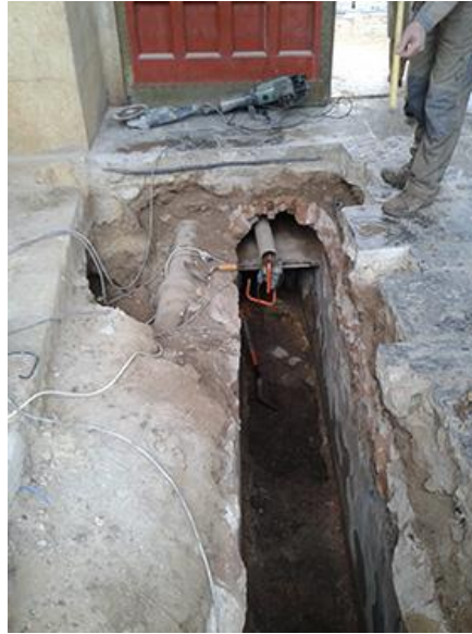
Ilustración 08. Vista de la excavación arqueológica en la Puerta de los Deanes. Rodríguez Cano construyó una cámara en la parte superior de la atarjea de Velázquez Bosco con el fin de alojar la tubería de la instalación contraincendios y no realizar una nueva afección a la cimentación de la Puerta. Elaboración propia.
