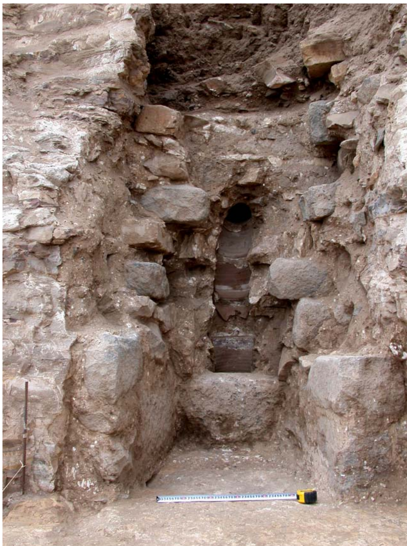
Lám. IX.—Registro de acceso a la conducción a presión.
