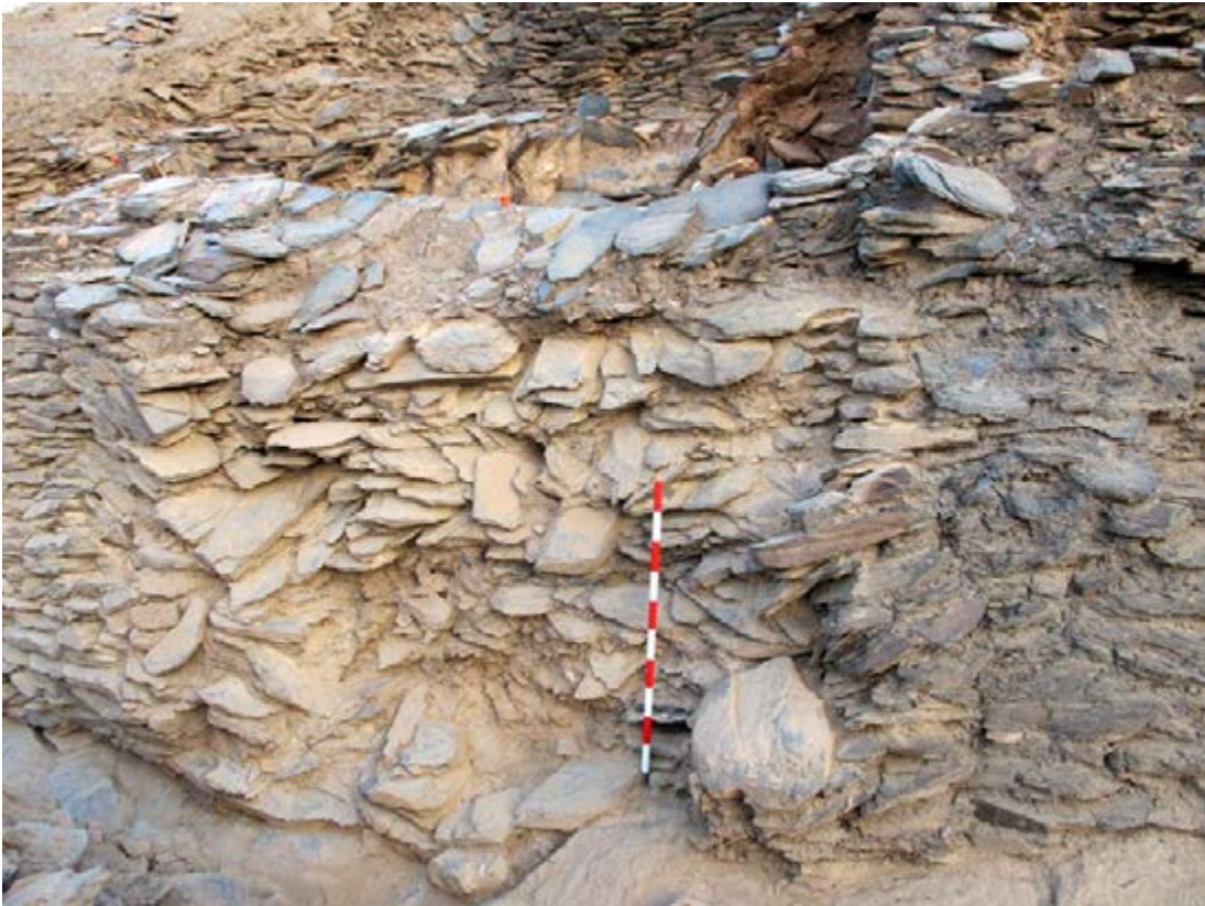
Lám. VII.—E-50.8 antes de su consolidación.
