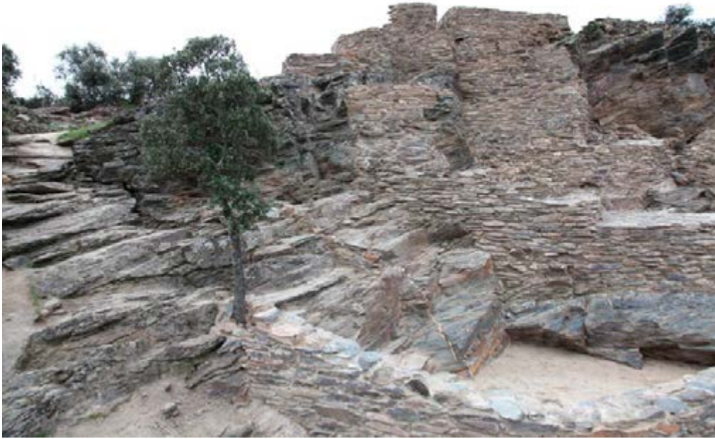
Lám. XVIII.—Estructuras consolidadas de la Ladera norte.
