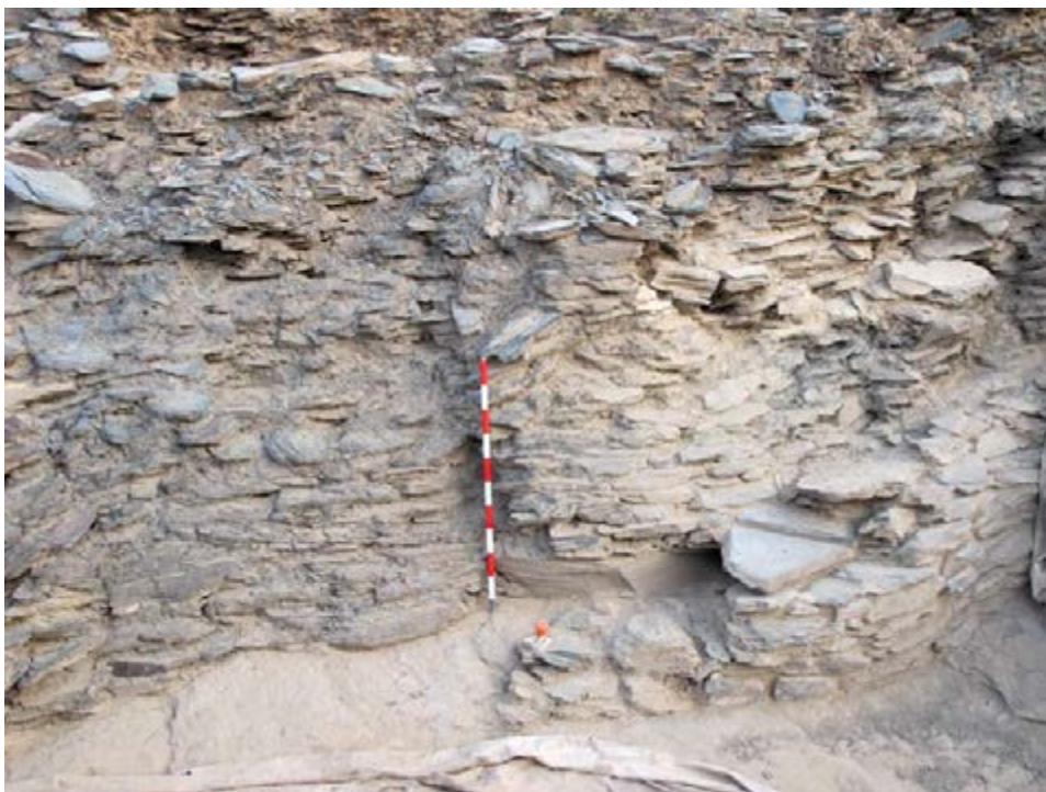
Lám. VIII.—Alteración de las pizarras en el frente sur de la muralla.
