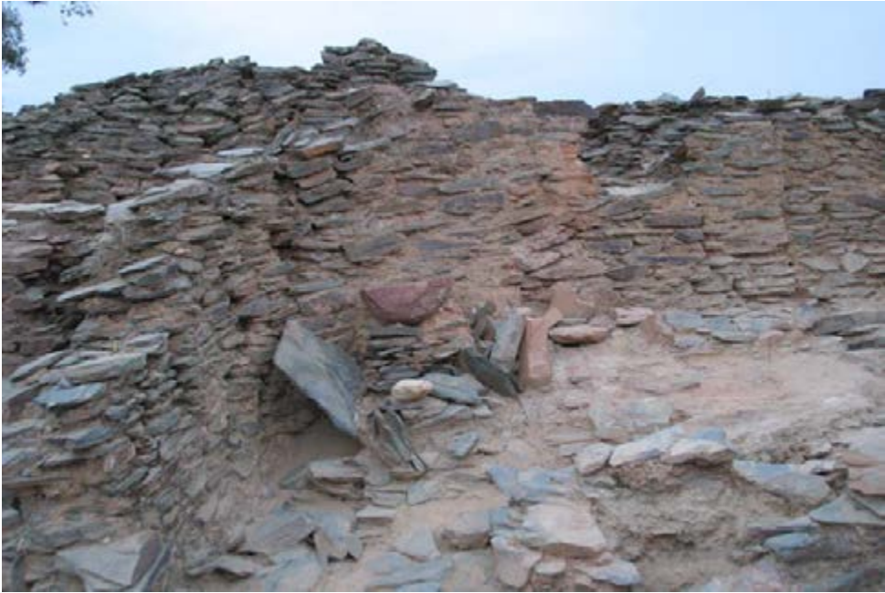
Lám. XIV.—Estado de conservación de los muros perimetrales del CE Xa.
