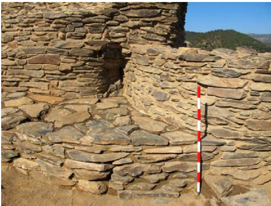
Lám. XII.—Consolidación de las estructuras 9.76 y 9.54.
