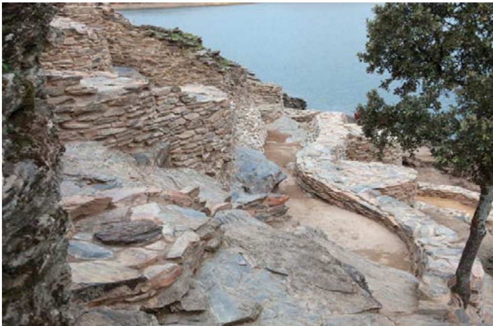
Lám. XIX.—Acceso a la acrópolis desde la Terraza Superior. Estructuras consolidadas.
