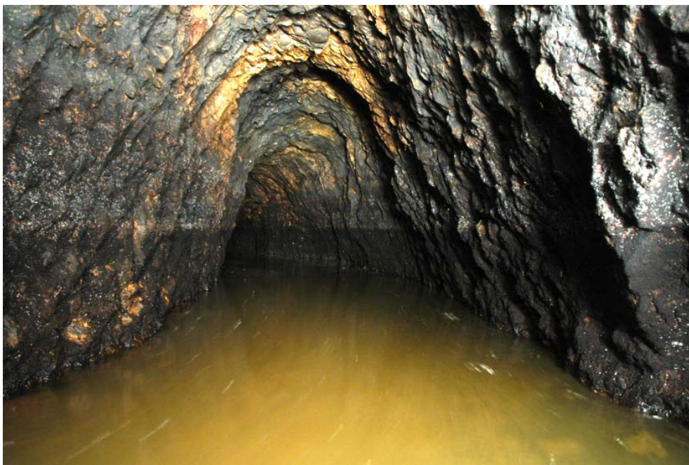
Lám. V.—Interior del socavón de desagüe Las Monedas (El Centenillo, Baños de la Encina).
