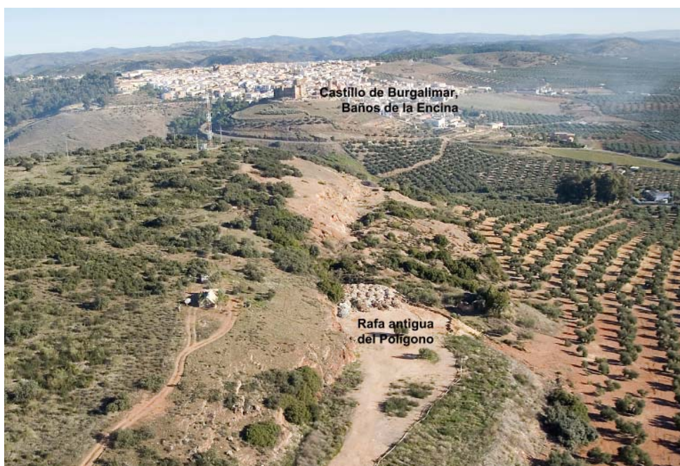
Lám. I.—Vista panorámica de la rafa del Polígono (Baños de la Encina).
