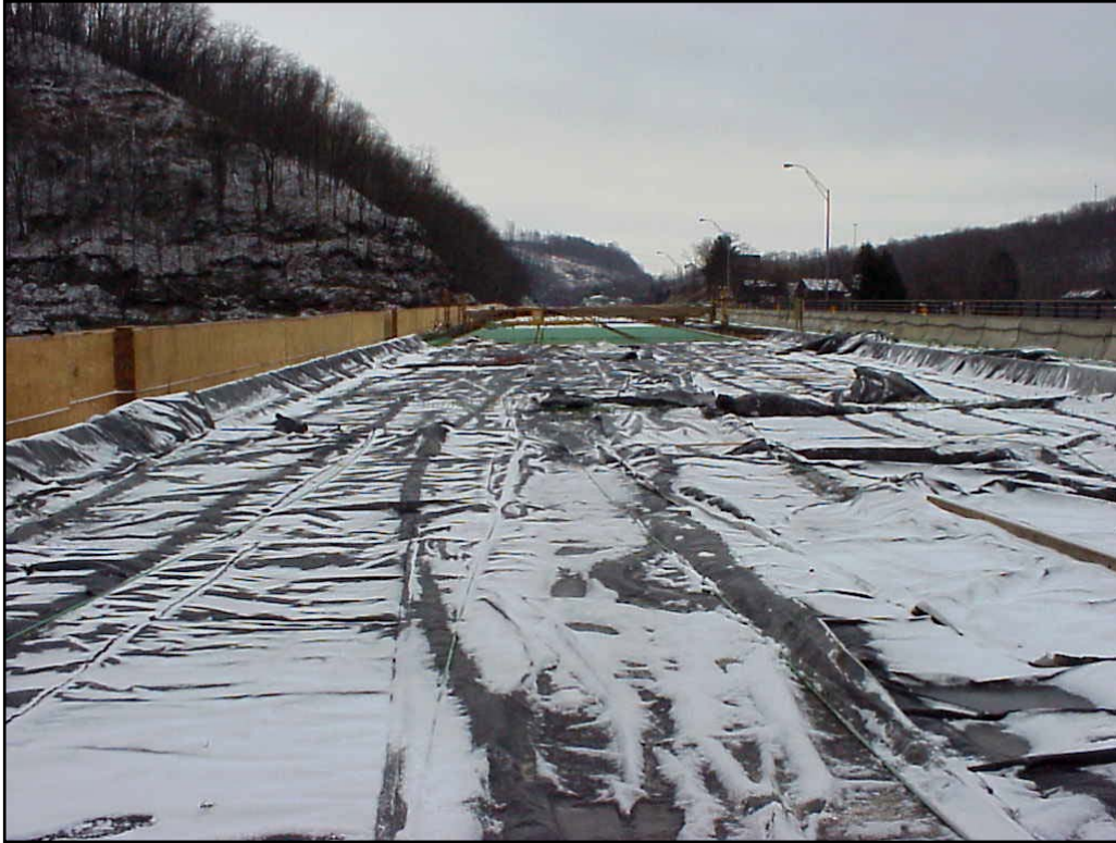
Figure 3.16 Thermal Blankets Covering Deck Pour No. 1
