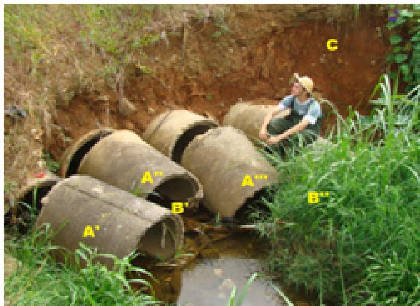
**Figura 3.** Seções fechadas com entulho e alteradas pela desestabilização do solo
